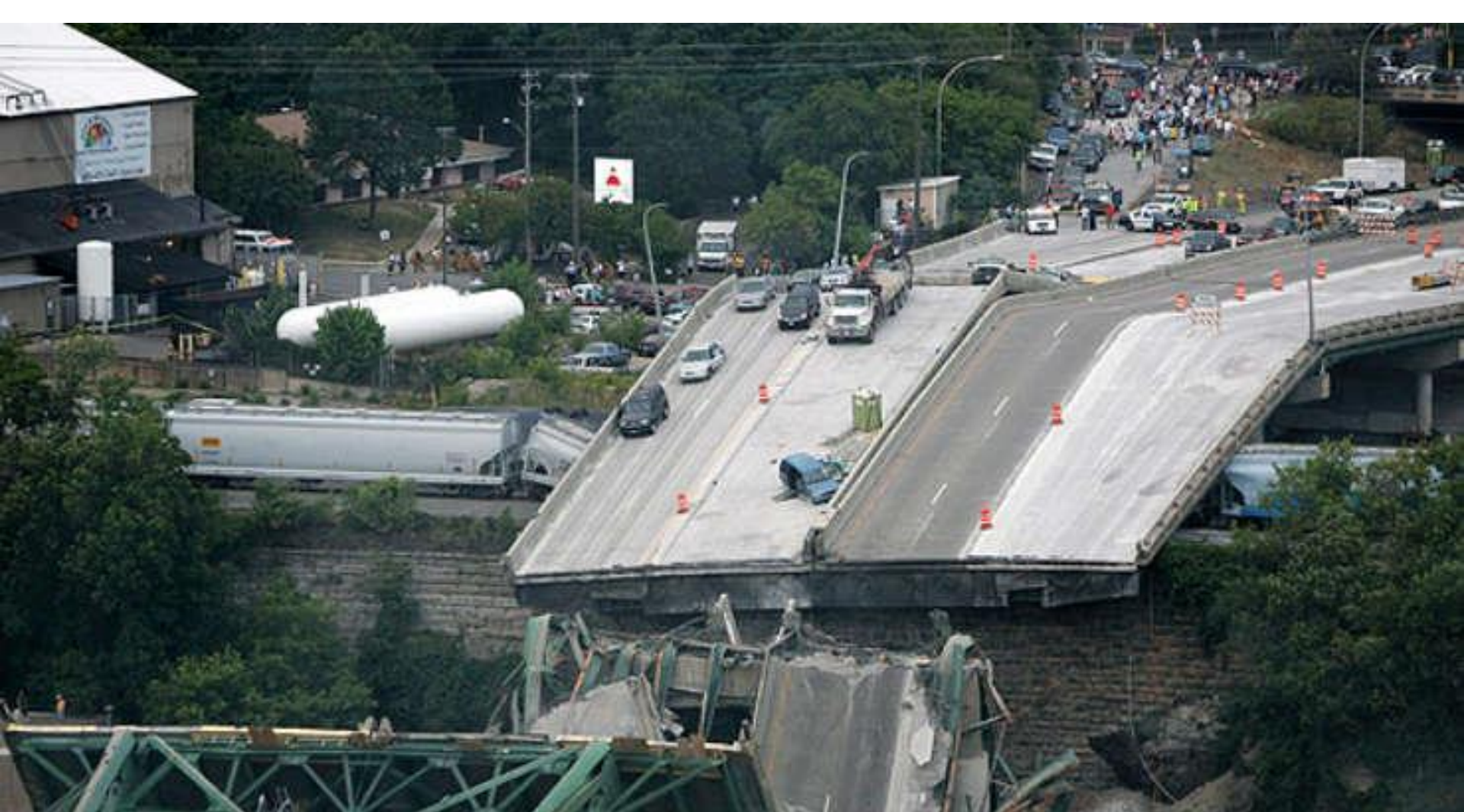
Colapso en agosto 2007
